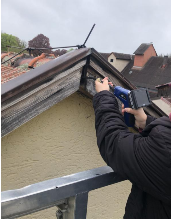
Abb. 9: Nachkontrolle einer Gebäudestruktur an den Lagerhallen mit dem Video-Endoskop.
