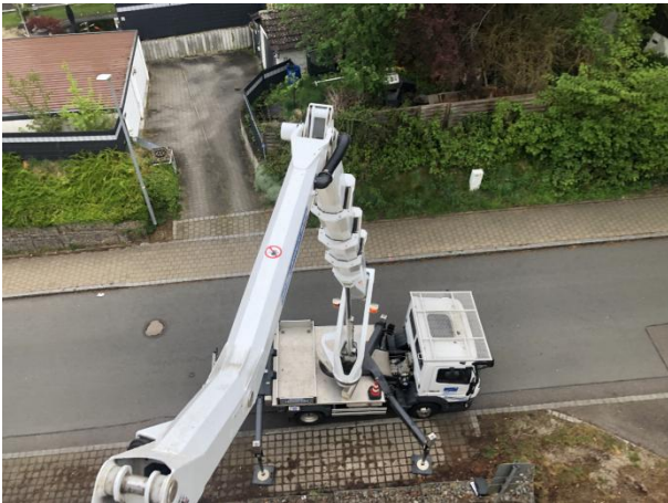
Abb. 8: Verwendung einer Hebebühne zur Nachkontrolle von Baum- und Gebäudestrukturen.
