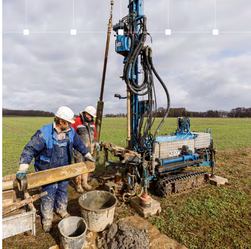
Maschine für kleine Sondierungen – das Bild zeigt die kleinste Drehbohranlage, zwischen Oberbachern und Ottenhofen kommen etwas größere Gräte zum Einsatz.
